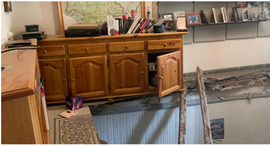
*Imagen de la habitación de la casa de Guillermo Rocafort en Jadraque tras producirse el derrumbe del forjado que le separa del local inferior*
