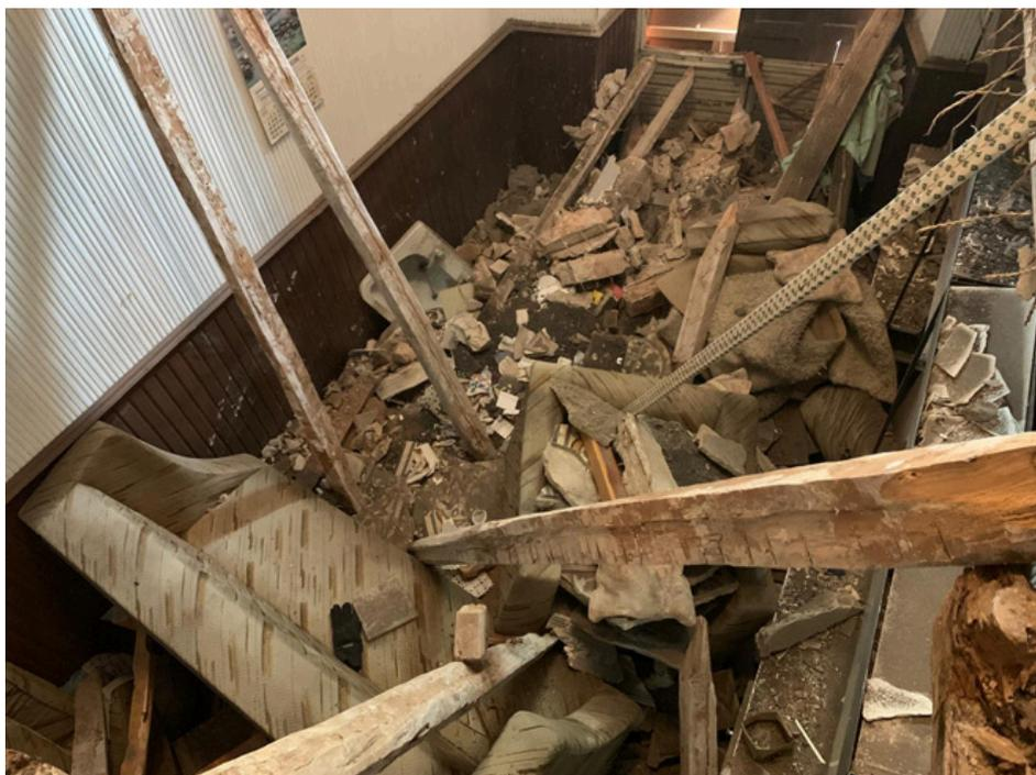
*Imagen de la habitación de la casa de Guillermo Rocafort en Jadraque tras producirse el derrumbe del forjado que le separa del local inferior.*
