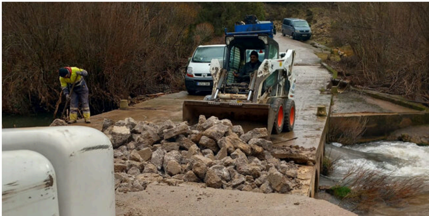
Imagen de la rehabilitación de uno de los puntos de paso afectados por la DANA en Cuevas-Labrada
