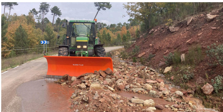
Labores de limpieza de la carretera de Ablanque (Guadalajara), tras la DANA del 29 de octubre
