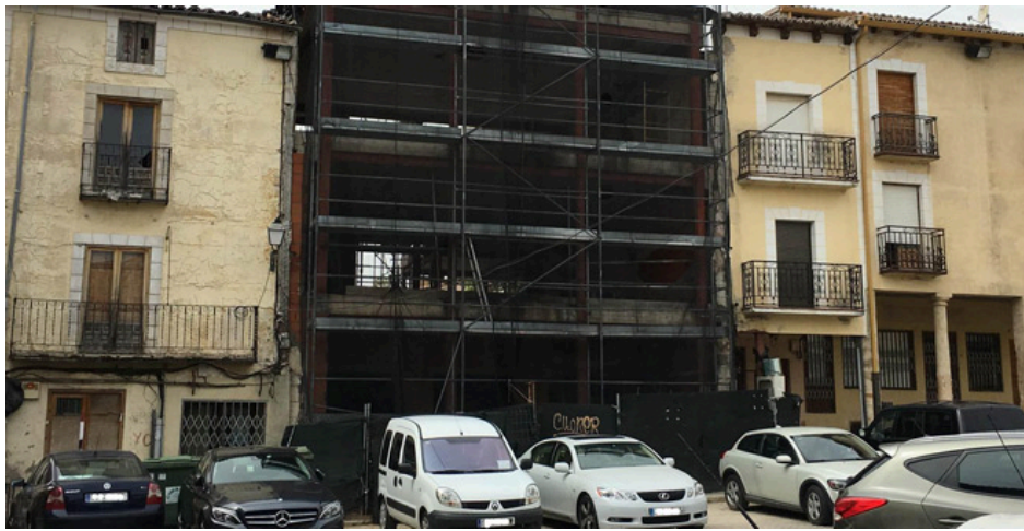
Plaza Mayor de Cifuentes. Imagen de archivo del viejo edificio del Ayuntamiento que fue derribado y las viviendas colindantes
